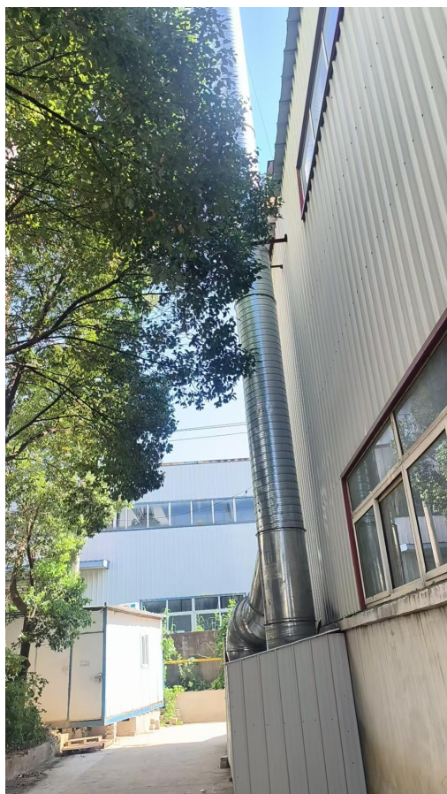
喷漆、晾干废气处理设施
